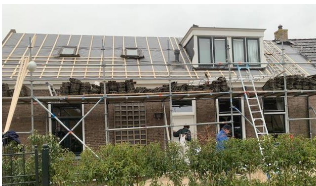
Foto 1: De dakisolatie in uitvoering
