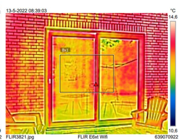
Achterkant na isolatie
