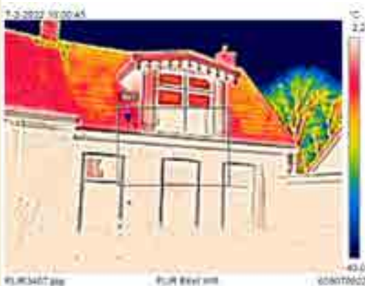
Foto 2: Het linkerdeel van het dak is dankzij de luchtdichte constructie beter geïsoleerd dan het rechterdeel terwijl rechts de laag isolatiemateriaal dikker is dan links.
