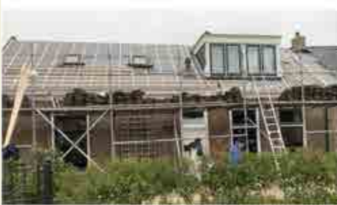
Foto 1: De dakisolatie in uitvoering
